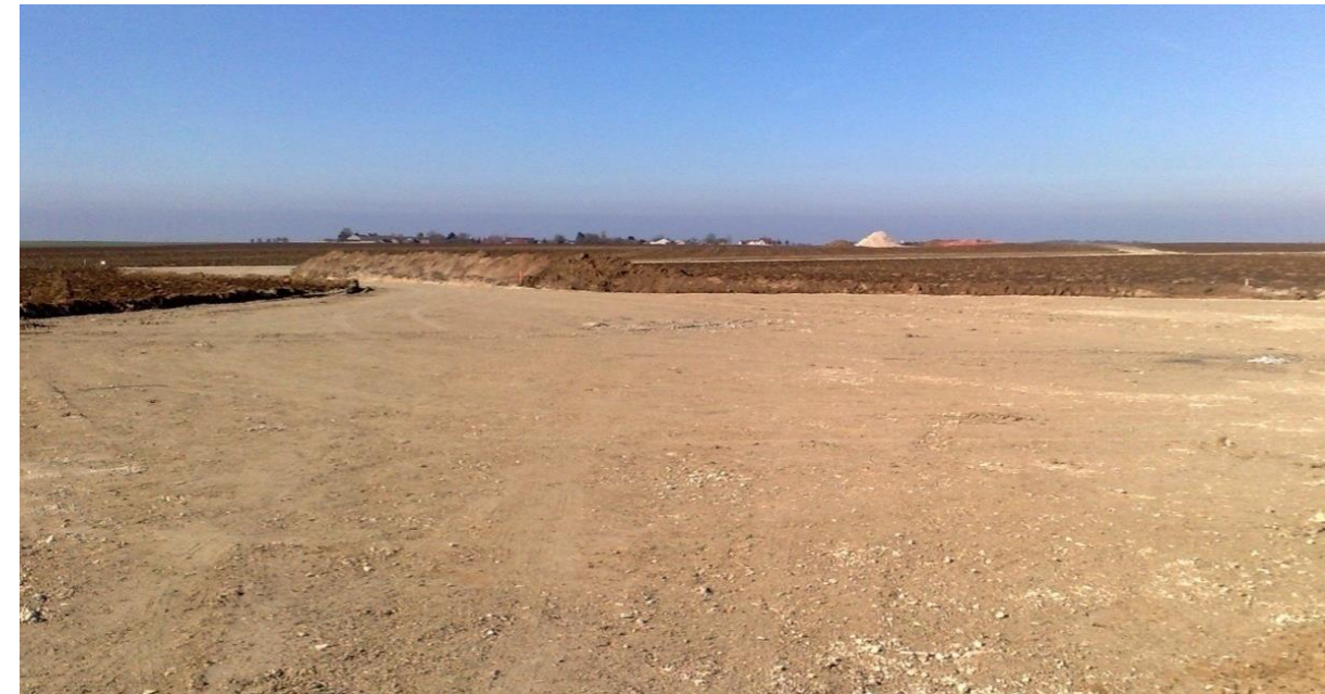
Figure 66 : Exemple d'aire de montage, grave compactée sur géotextile
